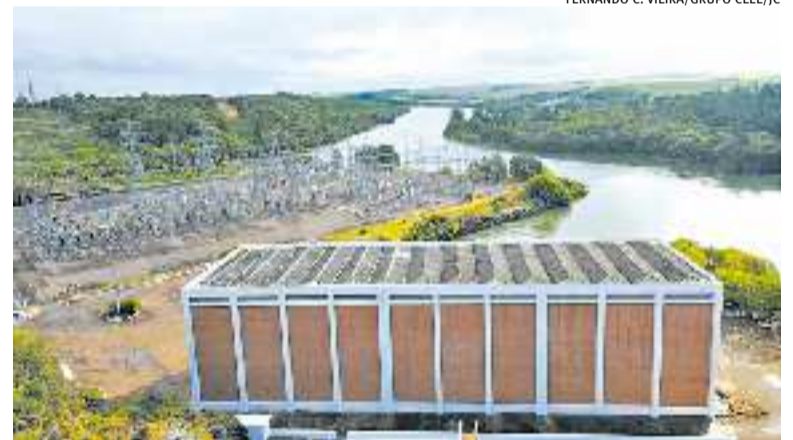
Hidrelétrica, em operação desde 1973, tem capacidade para gerar 159 MW
